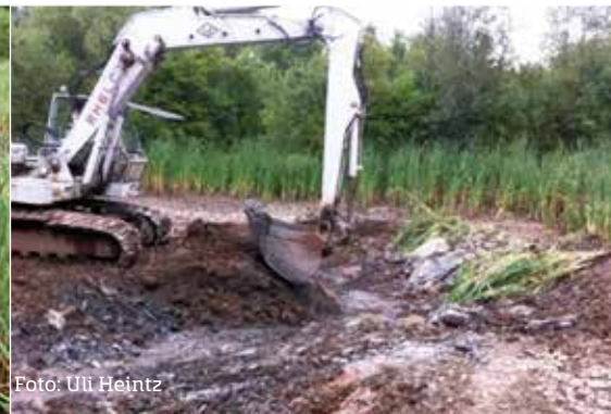
Ausbaggern eines verlandeten Weihers
