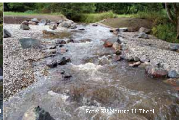
Sohlabsturz an der Theel nach Abriss
